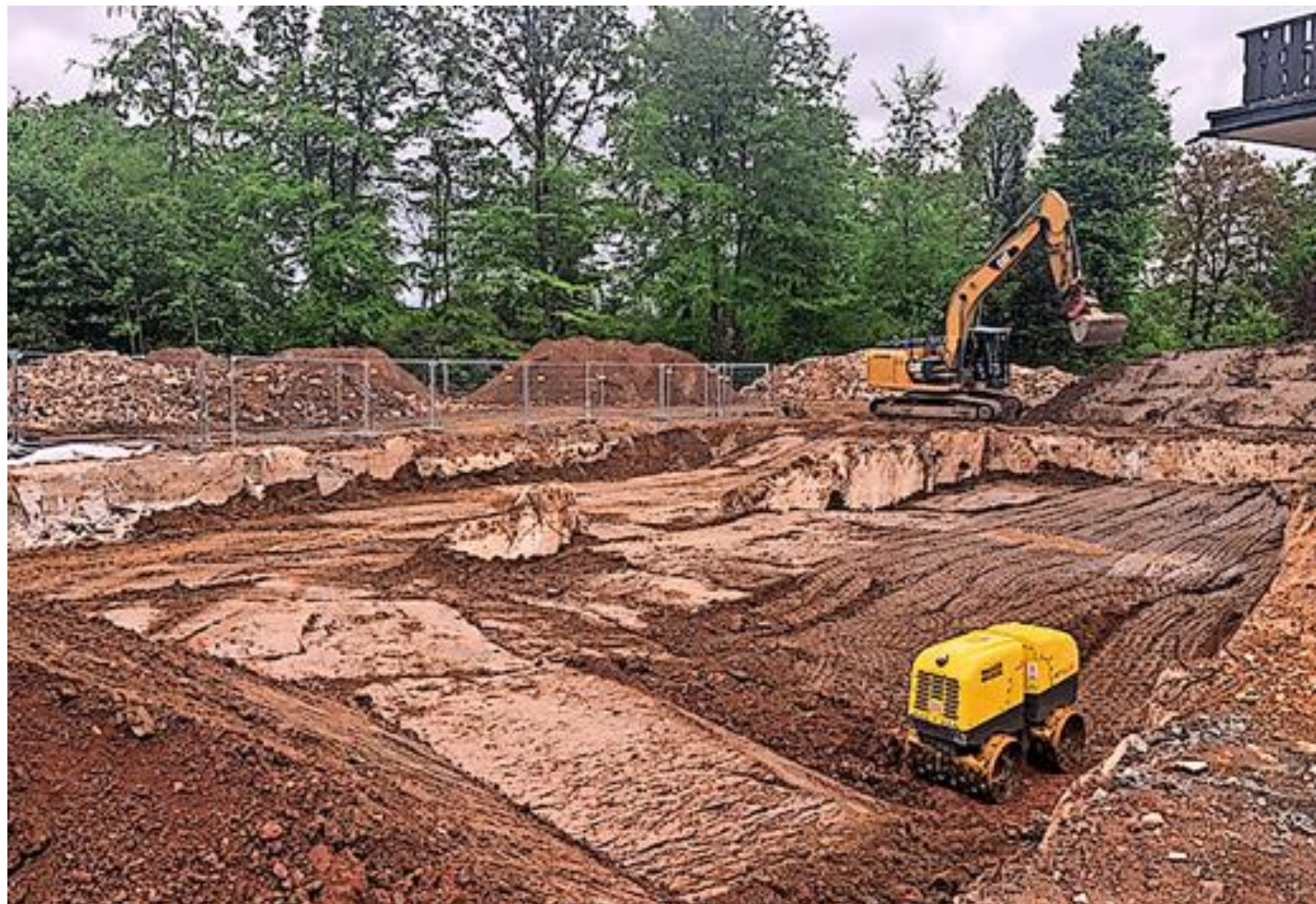
In der Saalestraße wurde seit Februar eine Rüstungsalblast aus Zeiten der Sprengstoffherstellung beseitigt.
