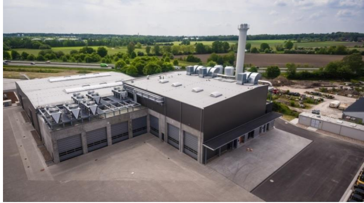
Zeppelin Power Systems – Motorenprüfstand Achim
