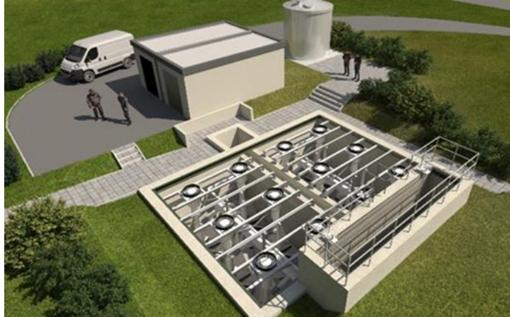
Sandfiltration auf der Kläranlage Bergen
