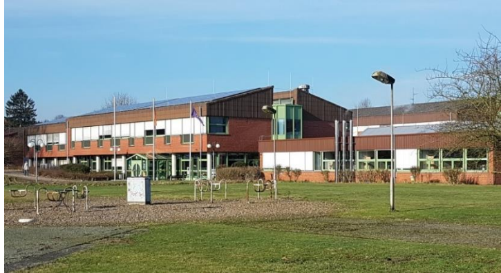
Berufsbildende Schulen Osterholz-Scharmbeck (Bestand 2018 vor Umbau / Sanierung)
