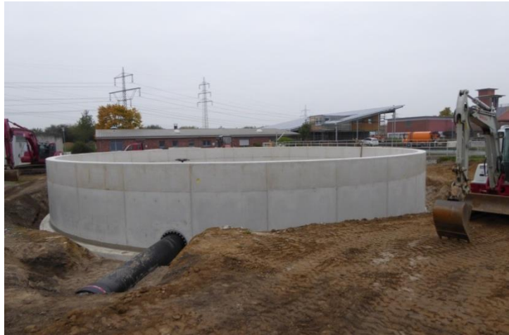
Neubau des Ablaufspeichers
