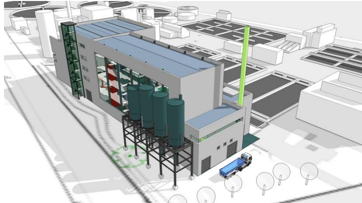
Klärschlamm-trocknungs- und Verbrennungsanlage mit Warte
