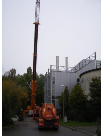
Demontage Kesselanlage und E-Filter
