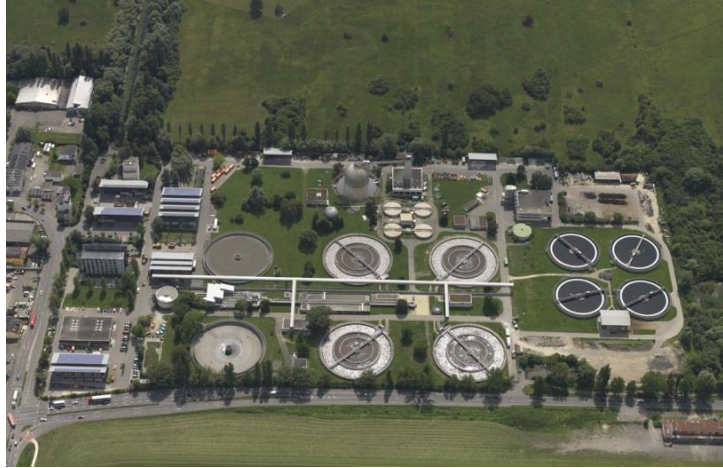
Luftbild Zentralkläranlage Konstanz
