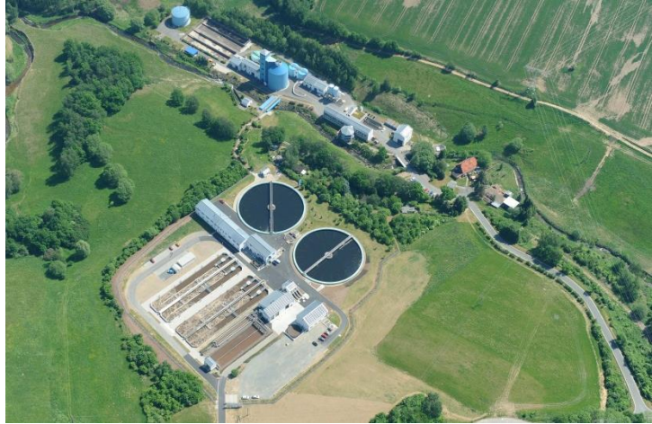
Luftaufnahme Zentralkläranlage Freiberg
