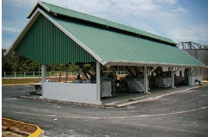
Annahmestation, im Hintergrund SBR-Behälter
