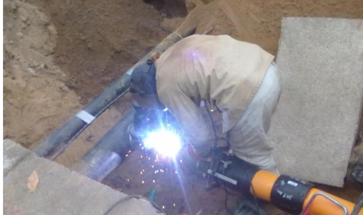
Anschluss an Leitungsbestand DN 300 Kesselsdorfer Straße
