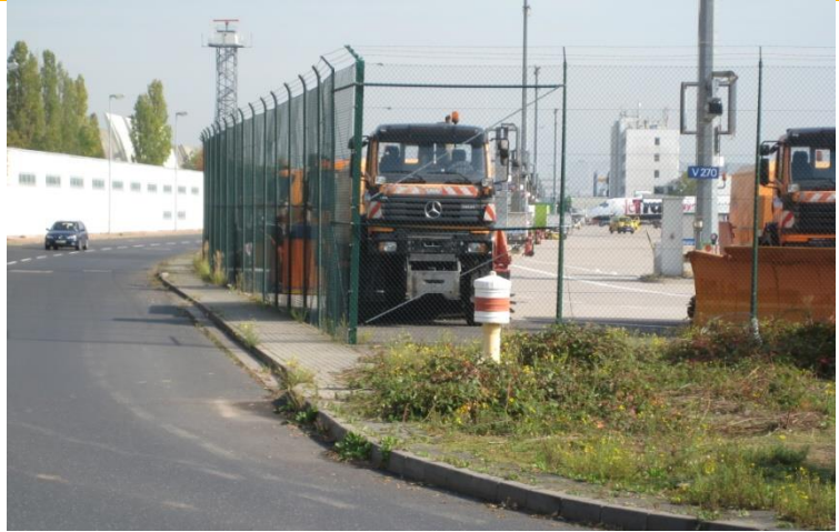
Flughafen Frankfurt, Hydrant zur Brauchwasserversorgung
