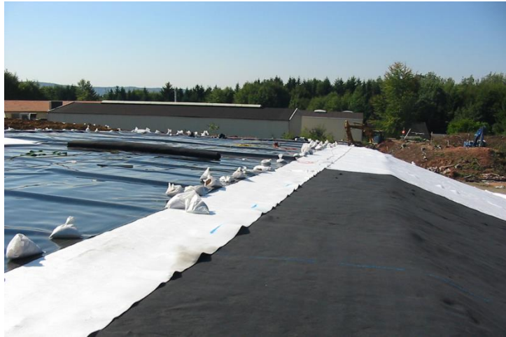
Aufbringung Oberflächenabdichtung
