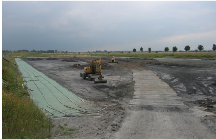
Restverfüllung Polder West
