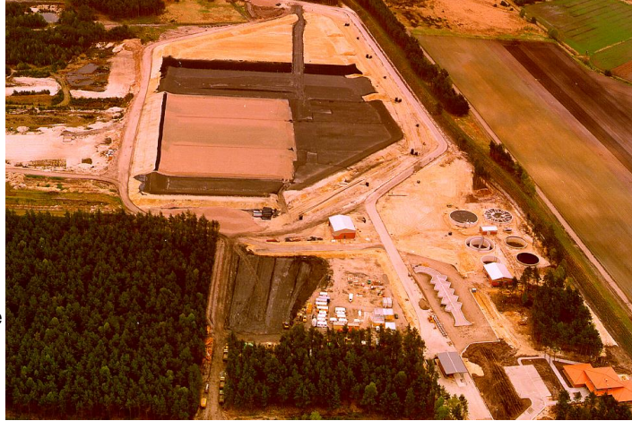
Bauarbeiten an der Abfallentsorgungsanlage Höfer
