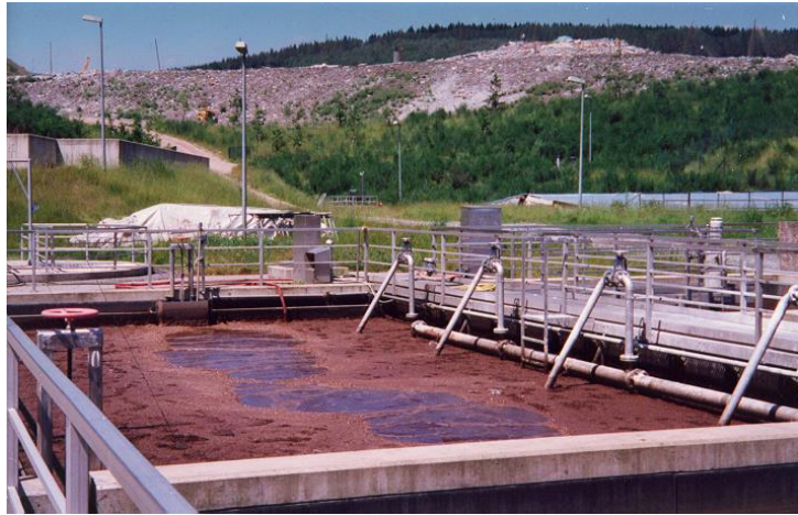
Belebungsanlage und Deponie "Alte Scheune"
