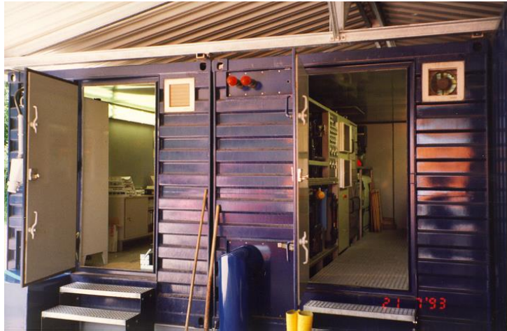
Steuercontainer (links) und Behältercontainer (rechts)
