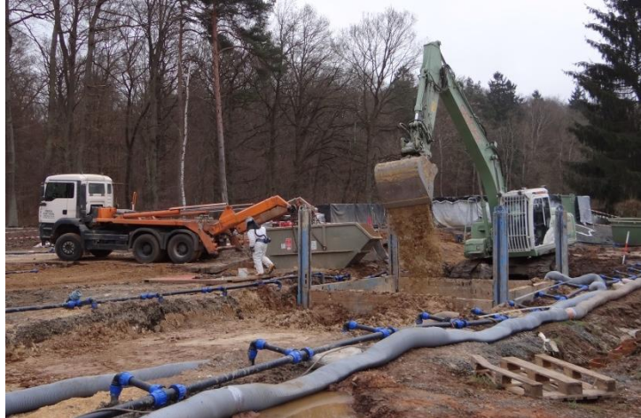
Aushub in Verbaukästen
