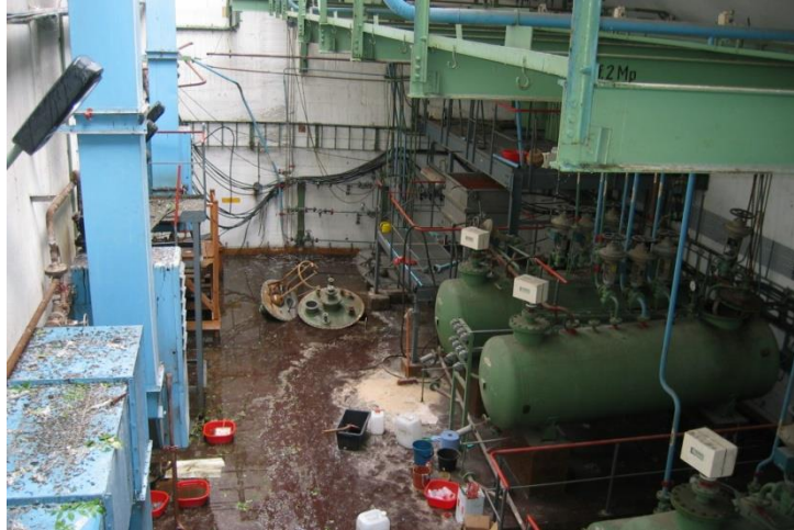
Reinigung Nitroglycerinlagertanks
