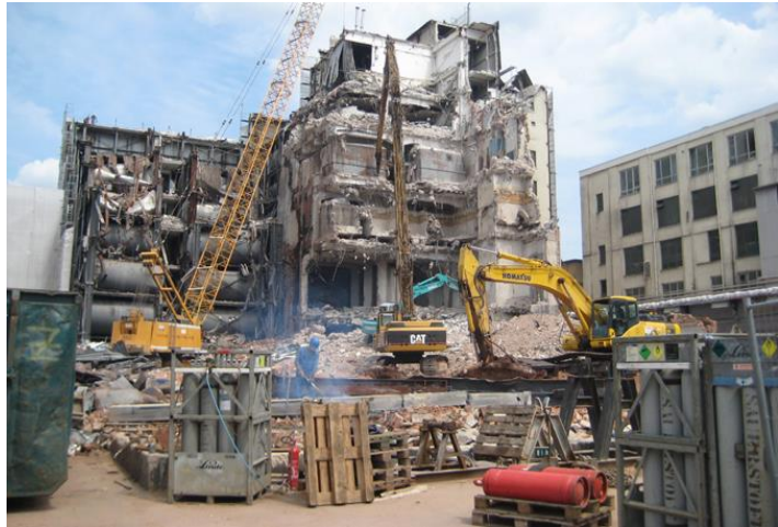
Rückbau Weserkeller mit liegenden Stahltanks
