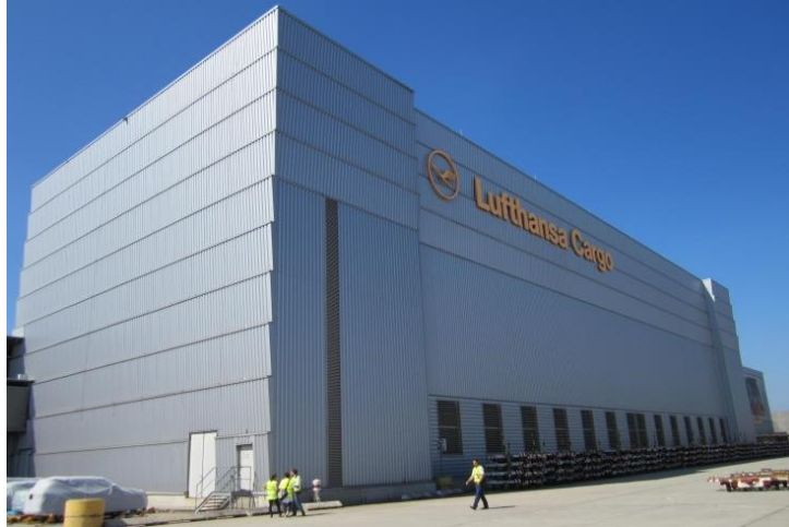
Ostansicht Gebäude 450-GLP-Stacker
