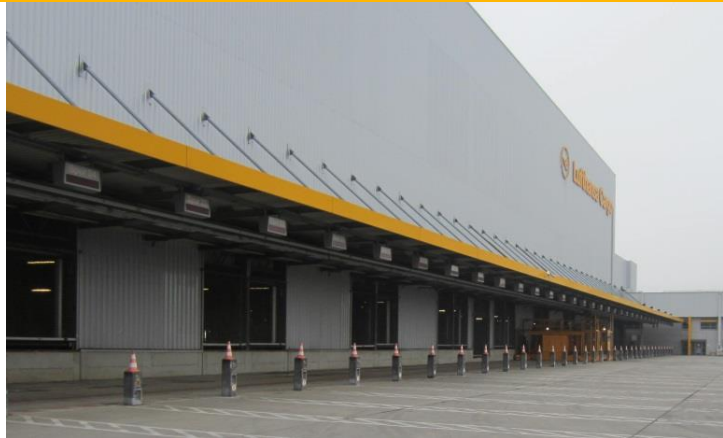
Nordwestansicht Hochregallager Geb. 449
