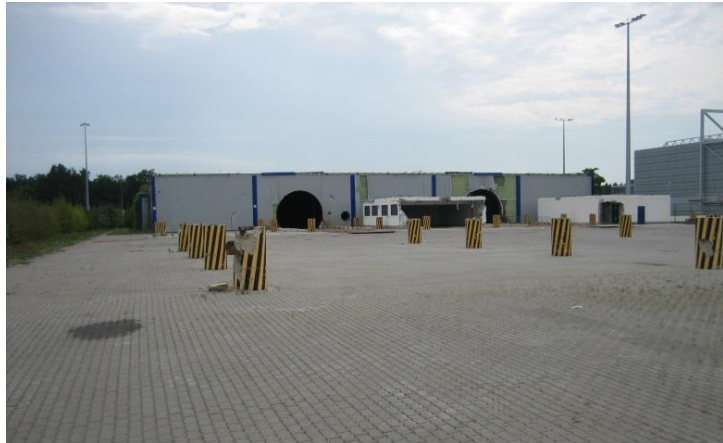
Nordansicht Simulationsanlage (Überdachung bereits zurückgebaut)
