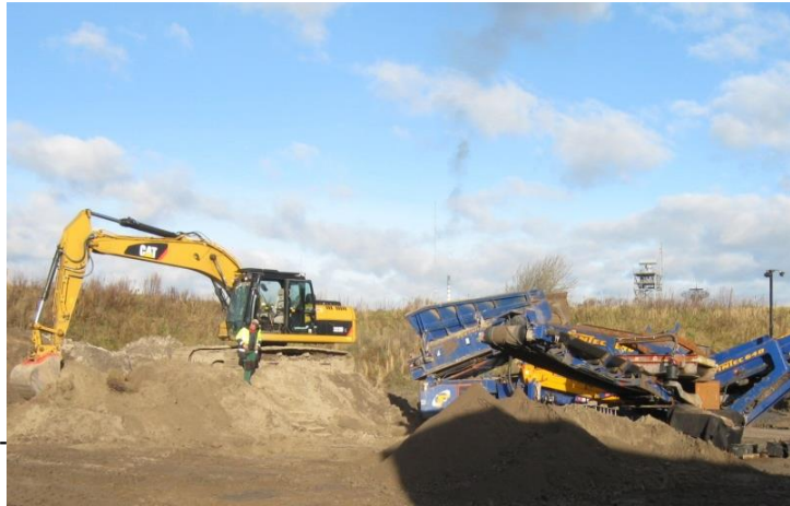
Bodensiebung zur Entfernung von Kampfmitteln
