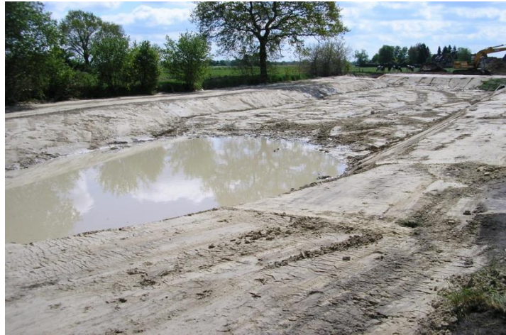
Staubehälter Blickrichtung Süden
