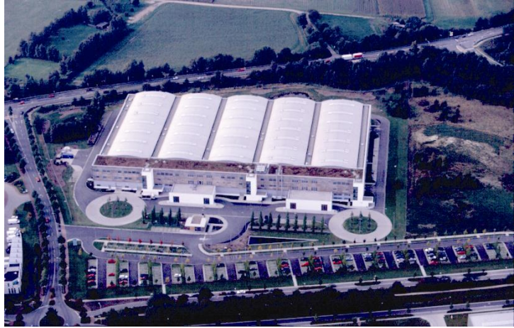
Produktionshalle in Achim
