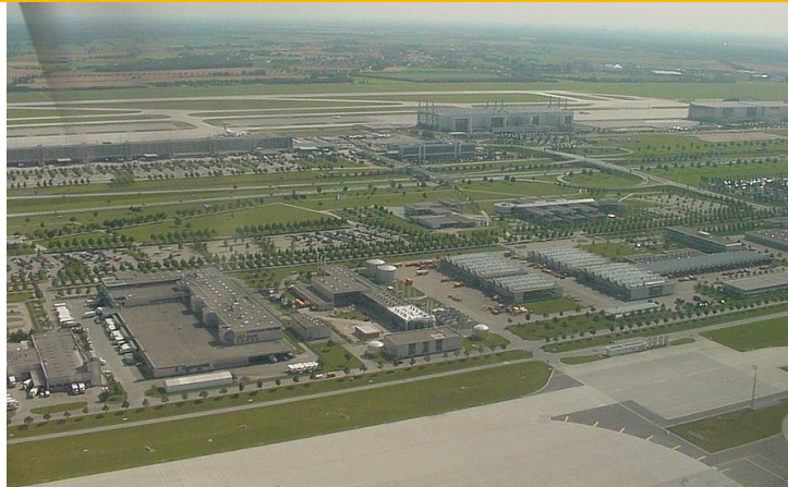
Energiezentrale Flughafen München
