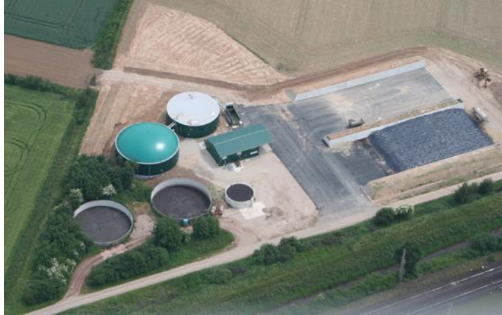
Luftbild der Biogasanlage
