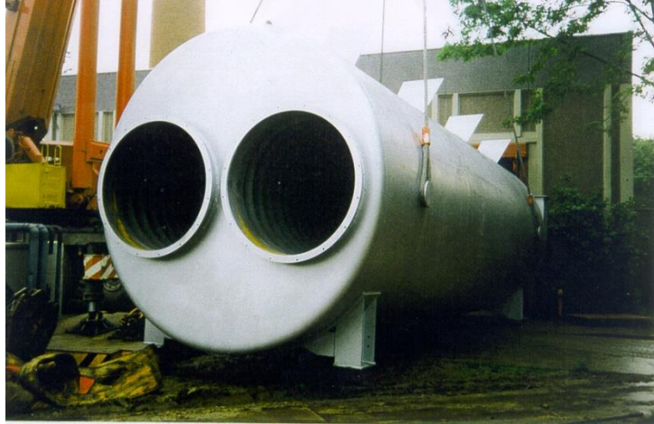
Anlieferung eines Heißwasserkessels (20 MW)
