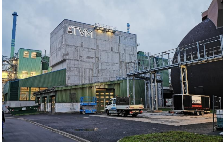
Klärschlamm-Trocknungs- und Verbrennungsanlage
