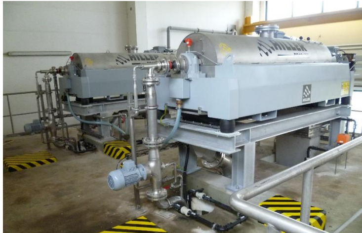
neue Entwässerungszentrifugen
