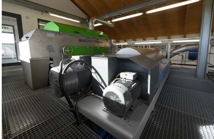
Klärwerk Bremen-Farge, Maschinenhalle
