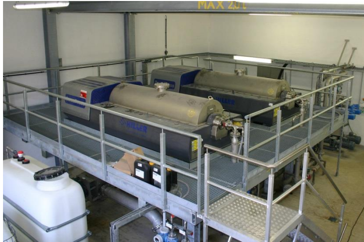
Hochleistungszentrifugen auf der KA Bergen
