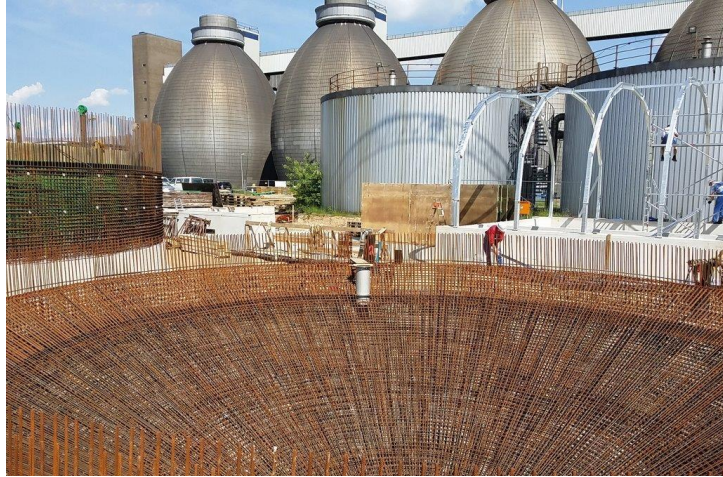
Baustelle Rohschlamm Speicher
