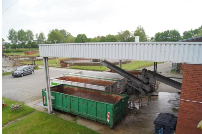
Schlamm Entsorgung Kläranlage Leer
