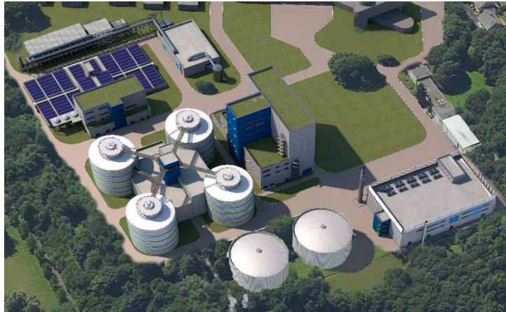
Faulungsanlage und Gasverwertung
