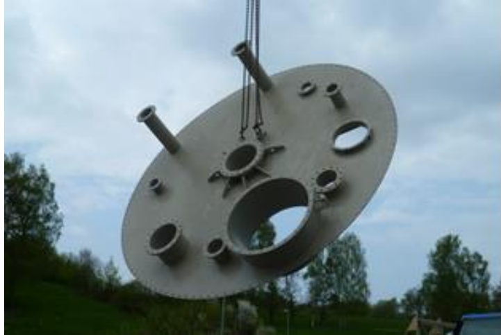
Montage Faulturmdeckel für Langwellenrührwerk
