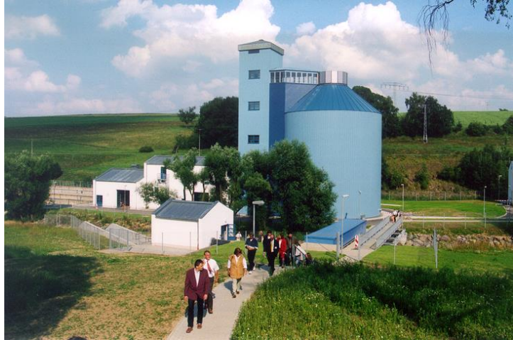
Faulbehälter der Kläranlage Freiberg
