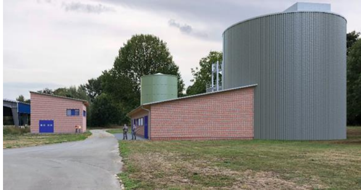
Schlamm-entwässerung und Faulung
