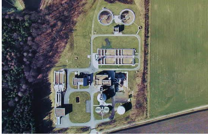
Luftbild der Kläranlage Bielefeld-Sennestadt
