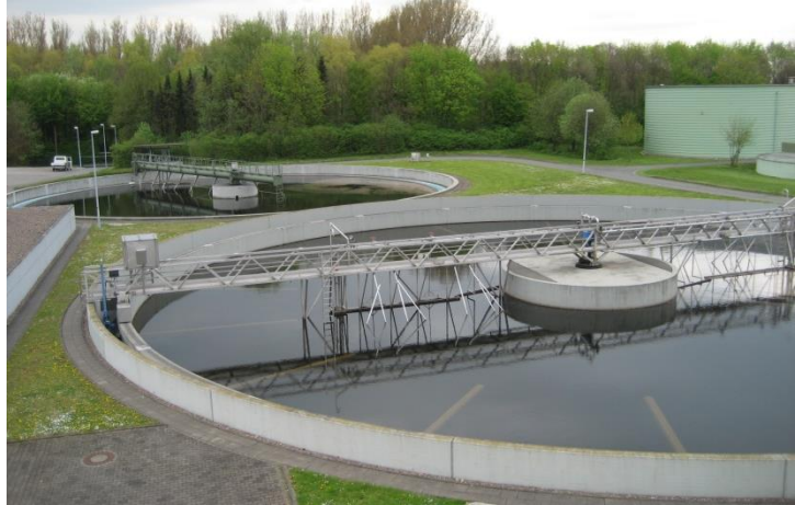
Kläranlage Bielefeld- Heepen
