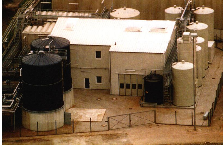
Luftaufnahme der Abwasserbehandlungsanlage
