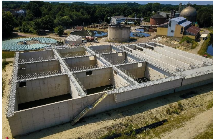
Stahlbetonarbeiten Belebungs- & Nachklärbecken
