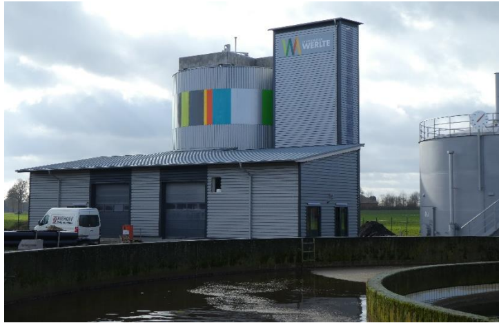
Neubau Schlammfäulung
