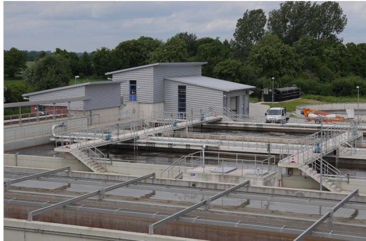
Übersicht über die Kläranlage
