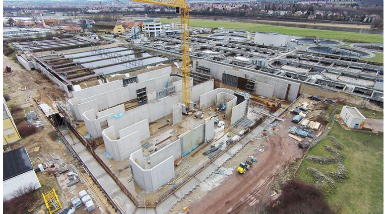
Erweiterung Belebungsanlage, 2. Bauabschnitt
