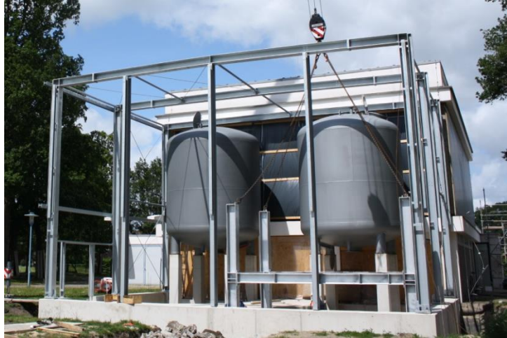
Aufstellung der neuen Filterbehälter
