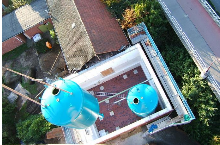
Montage der neuen Filterbehälter
