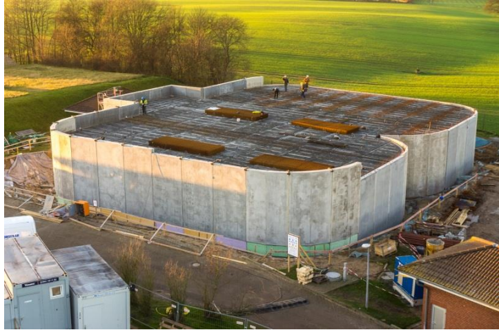
Reinwasserbehälter während der Deckenbewehrung
