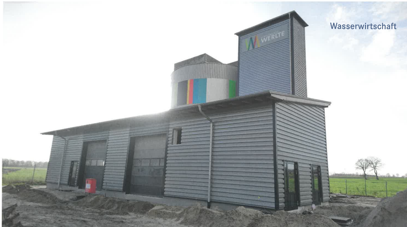
Kläranlage Werlte im April 2019
